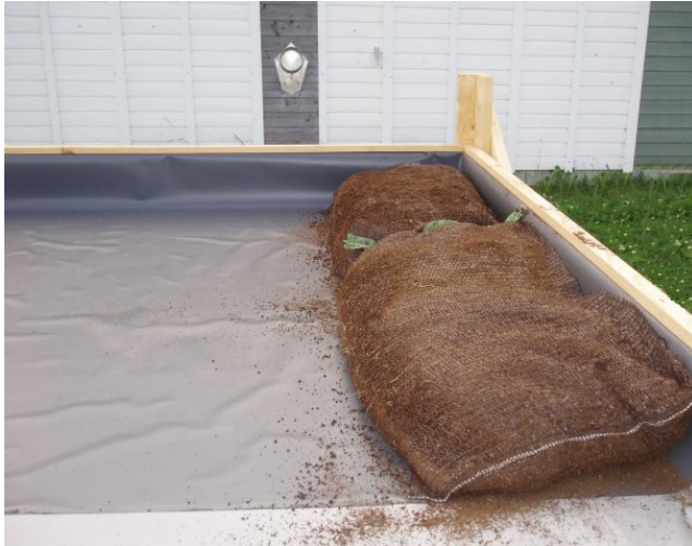
Figur 5 Montering av Nittedals Taktorv®.
